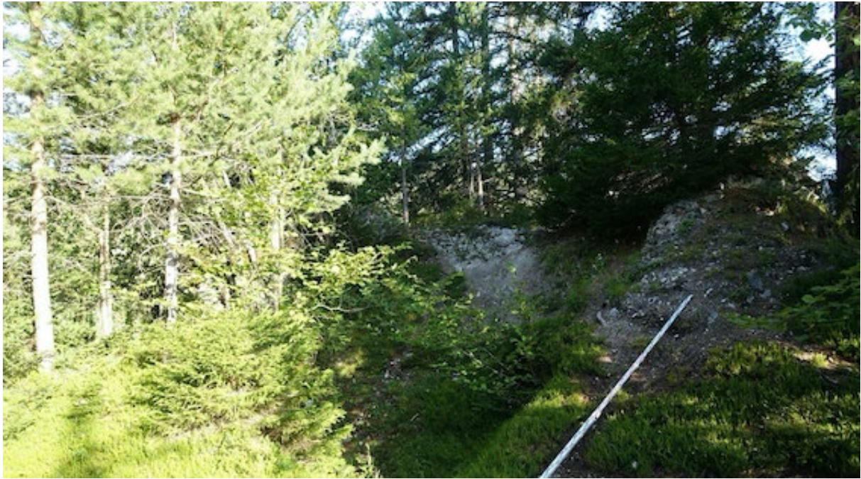
Abb. 1: Turm - Übersicht vor der Sanierung (Foto: ADG, 11.08.2020)
